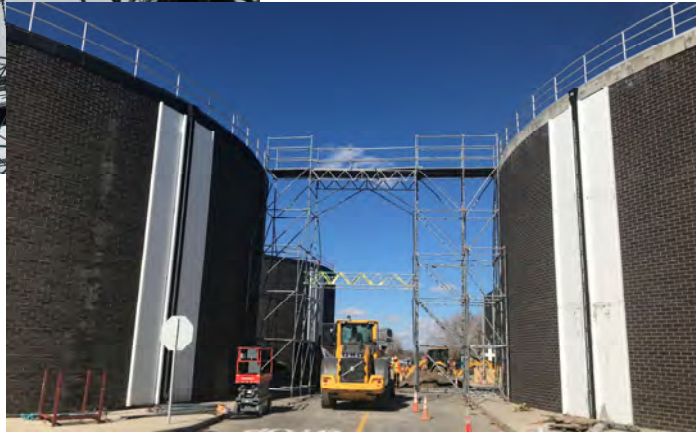
PAR 1259 – DIGESTER COMPLEX REHABILITATION
